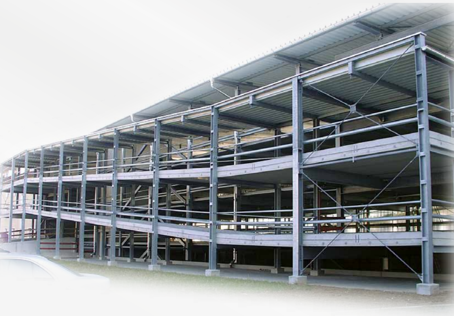
Stahl aus Thüringen im Einsatz bei einem Parkhaus in Köln
