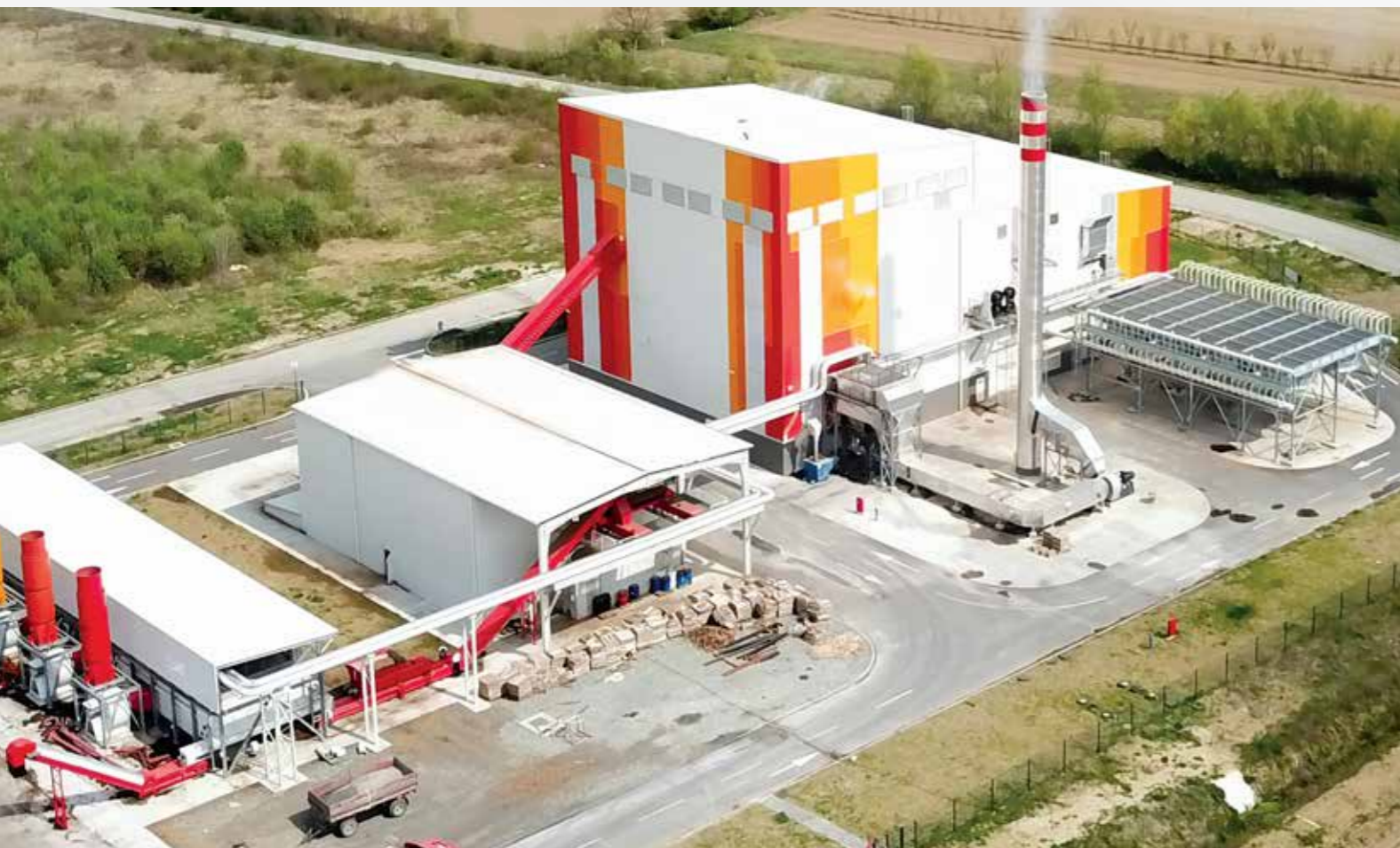
Stahl aus Thüringen im Einsatz bei dem Biomasse-Heizkraftwerk in Slatina
